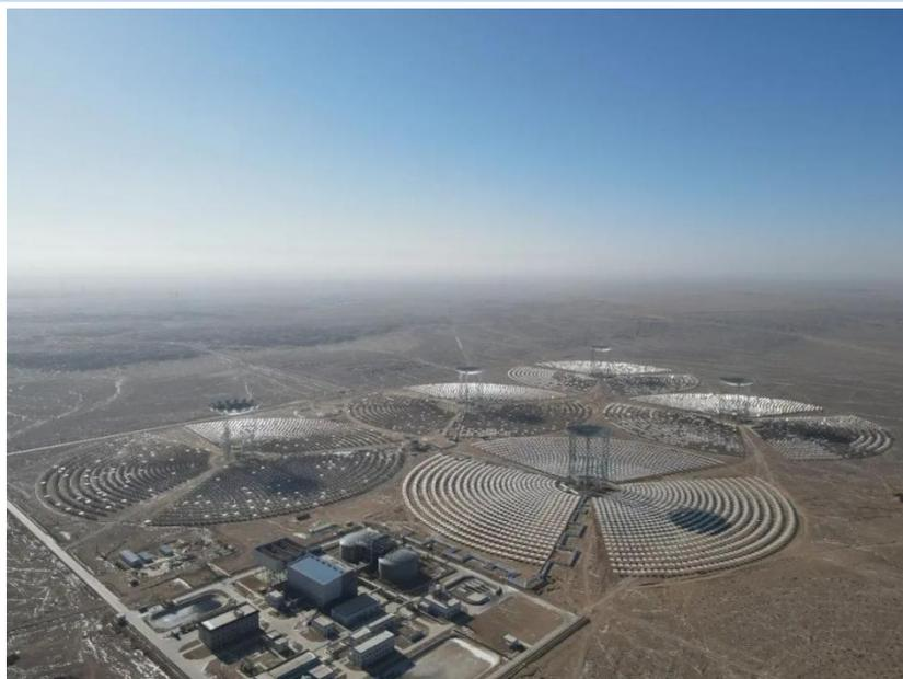
采用**鑫晨光热**自主研发的二次反射塔式技术的玉门鑫能 50MW 熔盐塔式光热发电项目是国家首批太阳能热发电示范项目，现已投运，进入试运行期。作为国际领先的二次反射塔式光热发电系统集成商，鑫晨光热目前在太阳能光热发电和储能等方向拥有 100 余项专利，其中核心发明专利超过 50 项，包含国际专利 2 项。公司拥有二次反射镜场聚光吸热系统和分布式熔盐储能系统等两大核心系统。
