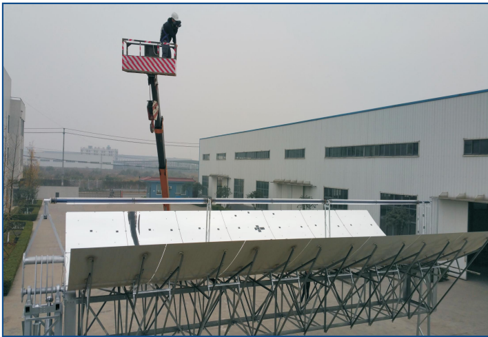
测量过程实景照片
