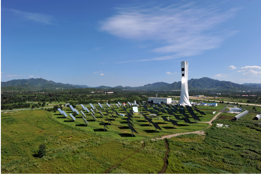
延庆八达岭电站吸热塔
