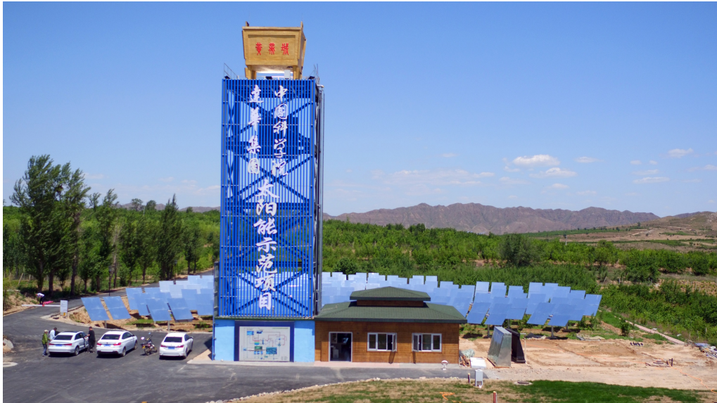
达华黄帝城太阳能跨季节储热项目(第一期)吸热塔
