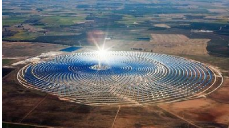
撒哈拉太阳能热发电站吸热塔
