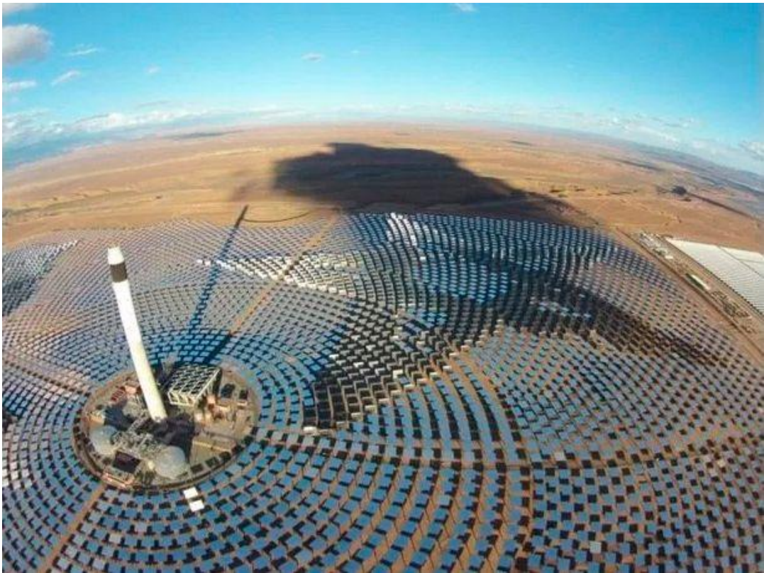
摩洛哥太阳能热发电站吸热塔
