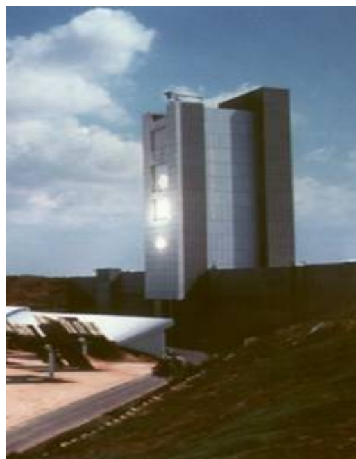
以色列 Weizman 太阳能塔式热电站
