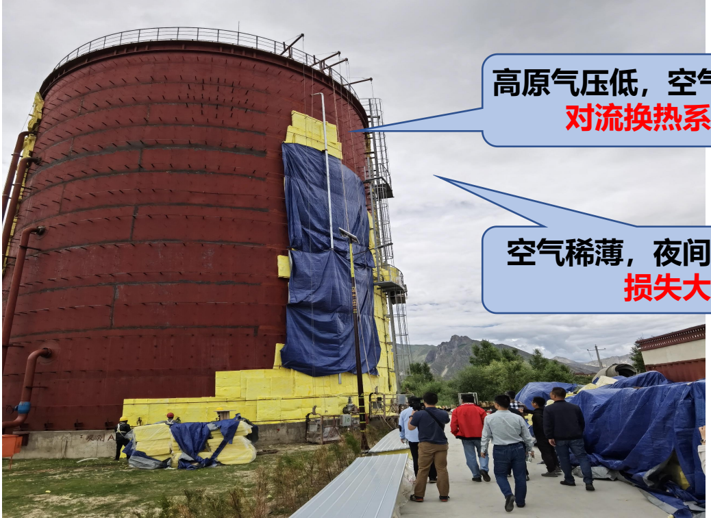
青藏高原某太阳能蓄热罐保温施工现场
