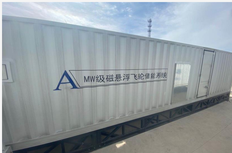
龙源电力山西风电混合储能调频
