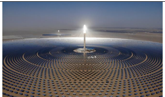
图 4：塔式光热发电项目
