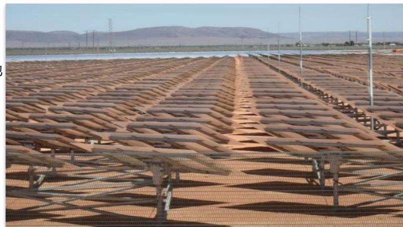
SEPCOIII定日镜基础无需混凝土浇筑，以某50MWe光热电站为例，耗钢量节省近半。
