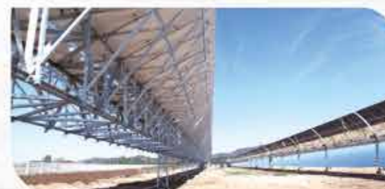
延庆863槽式集热试验平台建设项目
