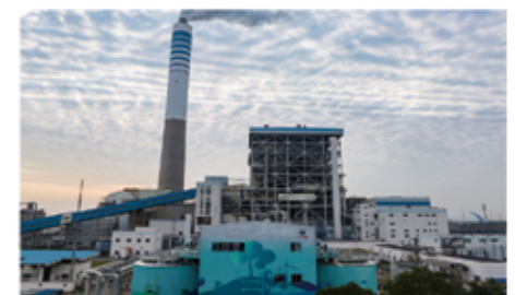
我司供货首个燃煤机组熔盐储能电站
