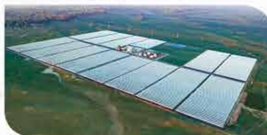
内蒙古乌拉特中旗100MW 10H储能 槽式光热发电示范项目
