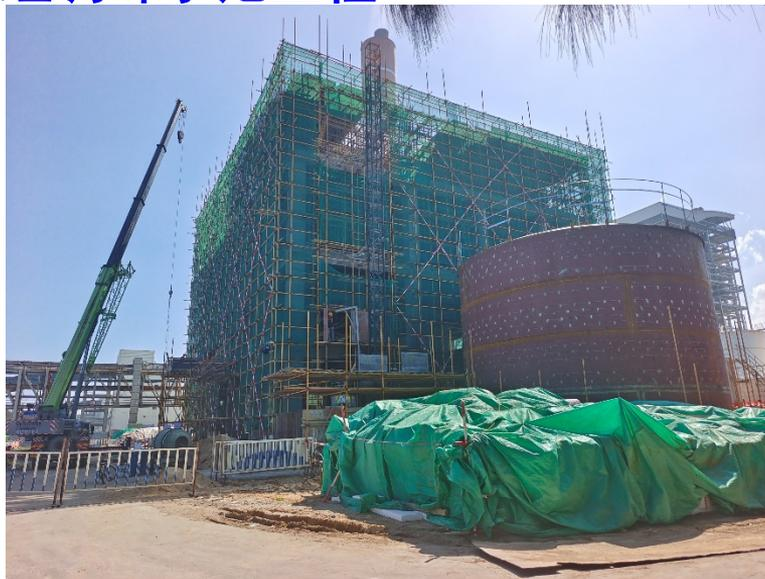
正在建设的**60MW-120MWh华能海门电厂高温熔盐储热火电机组调峰示范工程**：混凝土框架结构平台即将封顶，低温熔盐储罐基本完工，高温熔盐储罐完成约50%，电加热器、蒸汽发生器等主要设备已加工完成。
